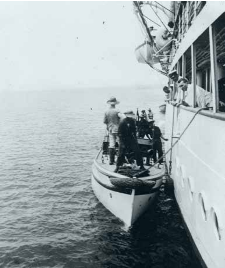
Peilvletten van opnemingsvaartuig Hr. Ms. Snellius worden gereed gemaakt om door de scheepssloep (voorground) naar een kust gesleept te worden. Foto genomen tijdens de Snellius-expeditie van 1929 tot 1931 in het Oostelijk deel van de Indische archipel. Deze stond onder leiding van gepensioneerd marineofficier P.M. van Riel. (NIMH)
